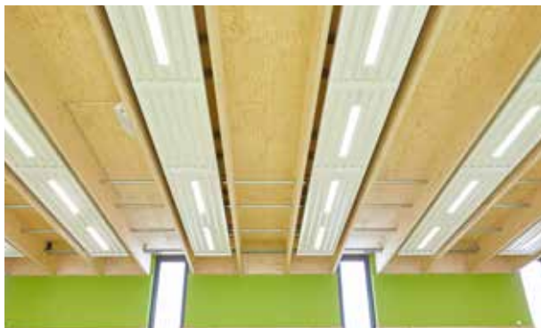
Passgenauer Einbau mit integrierter Beleuchtung
