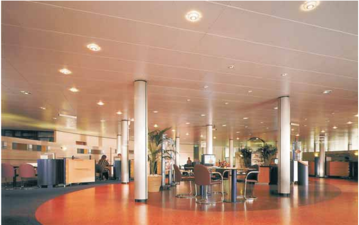
Eleganz in Verbindung mit optimaler Funktion – die aktive Kassettendecke zum Heizen und Kühlen in einer Bank
