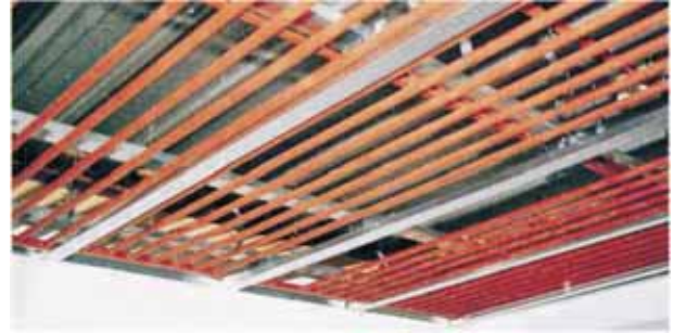
Deckenkonstruktion mit allen 1/2"-Registerrohren
