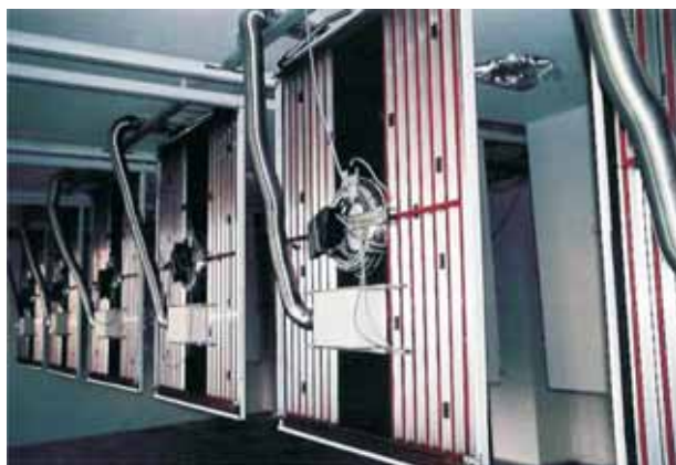
Abklappbares, aktives Segel zum Heizen, Kühlen, Lüften und Beleuchten
