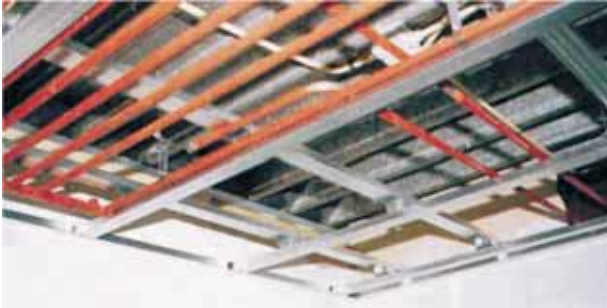
Unterkonstruktion, teilweise schon mit Registerrohren
