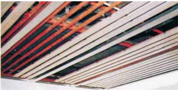
Decke mit Wärmeleitprofilen
